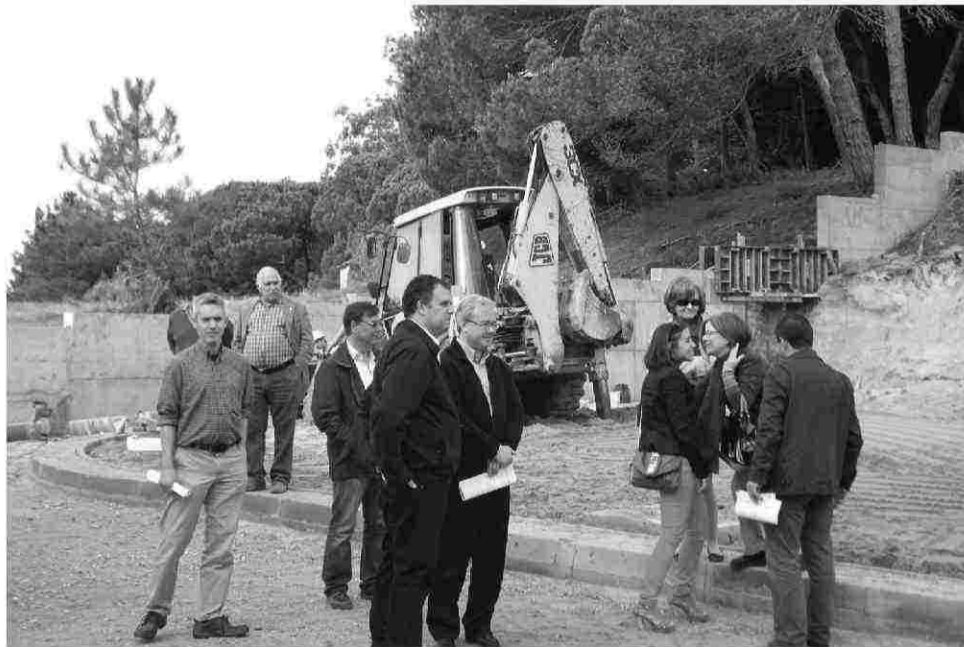
Janas – Aspecto das obras em curso
